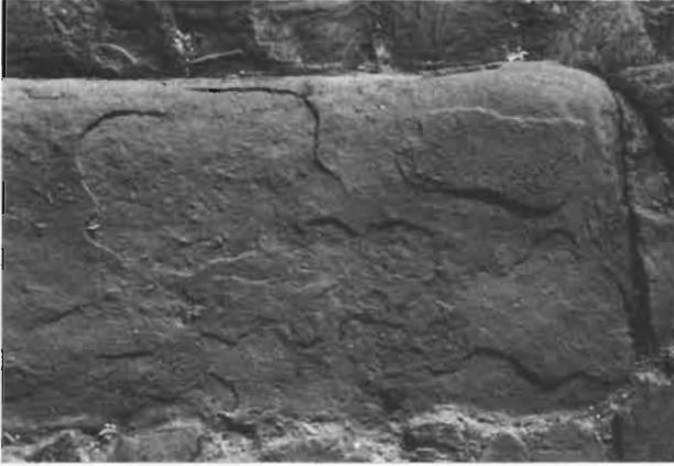
**Figura 1 – Descamación y arenización de shoshonitas por intemperismo y por oxidación de micas y hornblenda**
