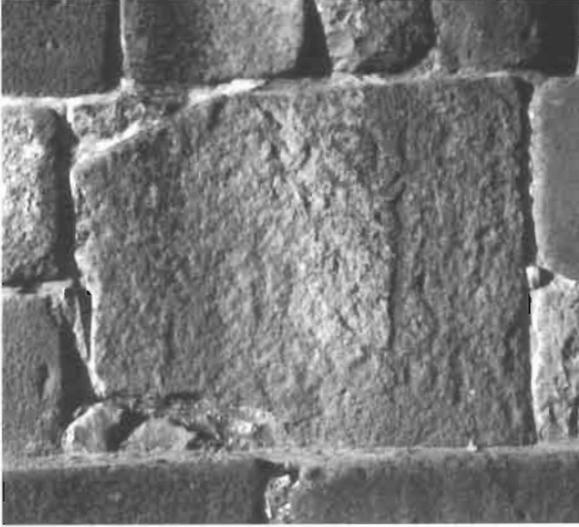
**Figura 4 – Andesita afectada por disgregación por alteración mineralógica (oxidación de micas y hornblendas principalmente)**
