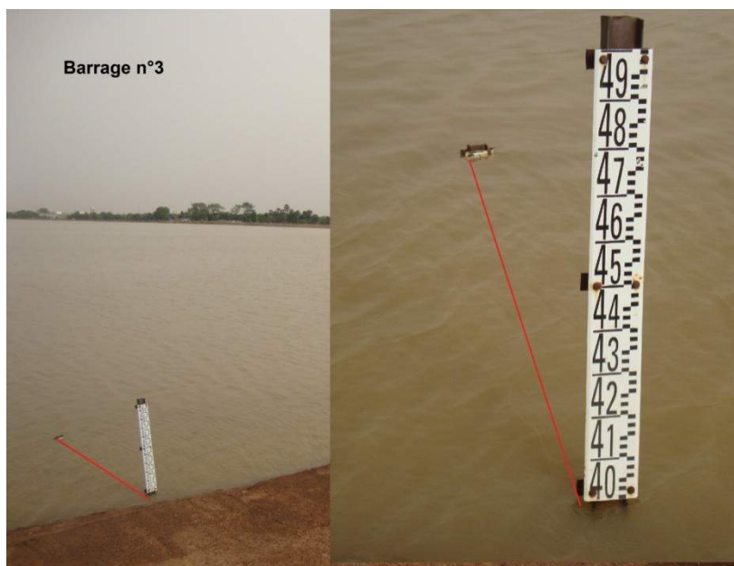
Figure 1. 3 : Echelle de mesure de la hauteur d'eau au barrage N° 3
