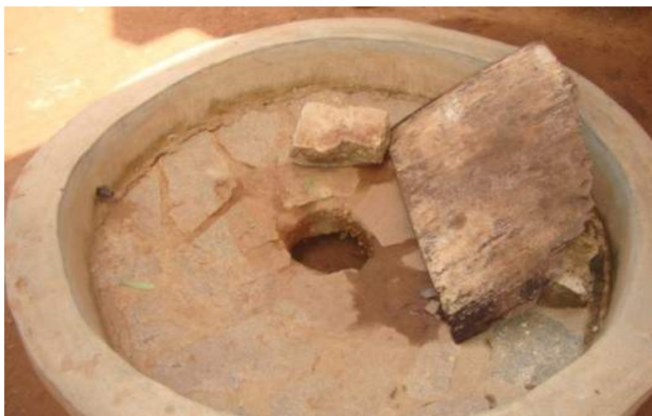
Figure 1. 12: Trou de recharge artificielle de la nappe à l'aplomb du toit du restaurant universitaire.
