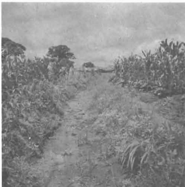
Rigole d'évacuation au profil stabilisé : fond carapacé, bords enherbés
