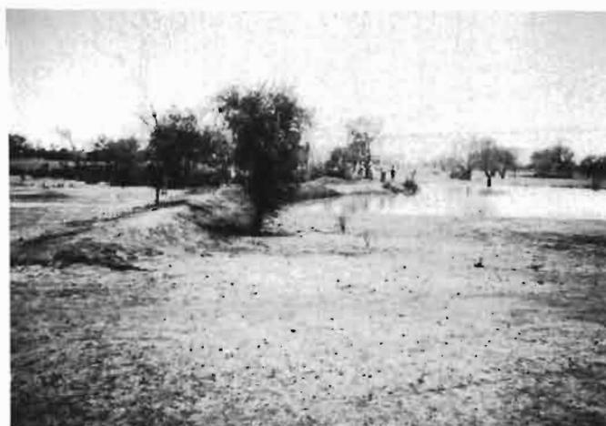
3. Petit barrage collinaire sans exutoire construit par une communauté de Ziga pour les besoins en eau des hommes et des bêtes, pour la recharge de la nappe et pour l'irrigation de petits jardins.
