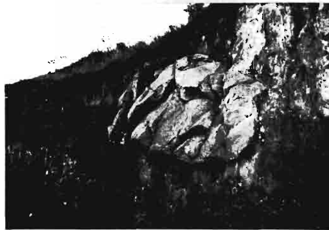
route TANANARIVE-ANTSIRABE altération en boule
