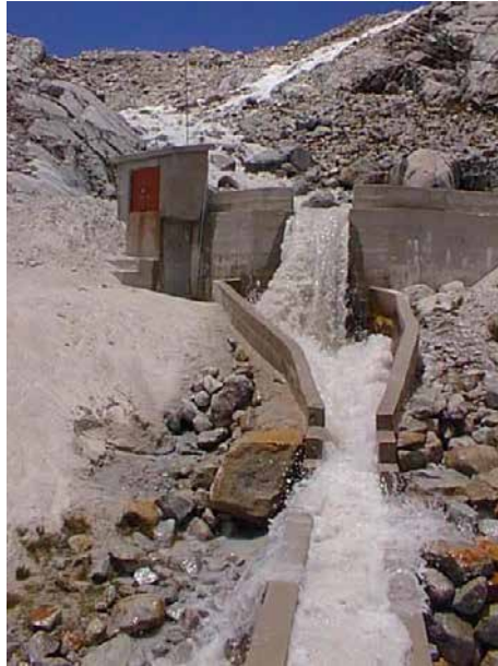
Figure 1.5. Station de jaugeage à 4830 m
