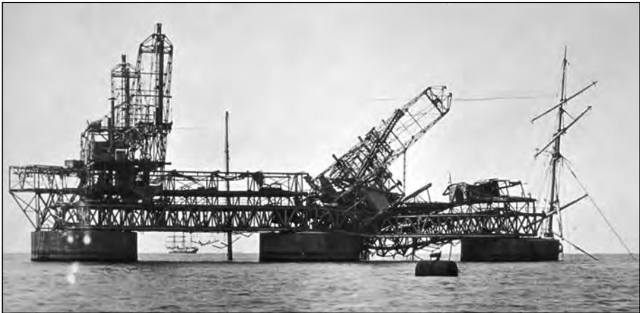
**Fig. 8. Le transbordeur en mer endommagé et l'épave de la *Joliette*<sup>21</sup>.**
