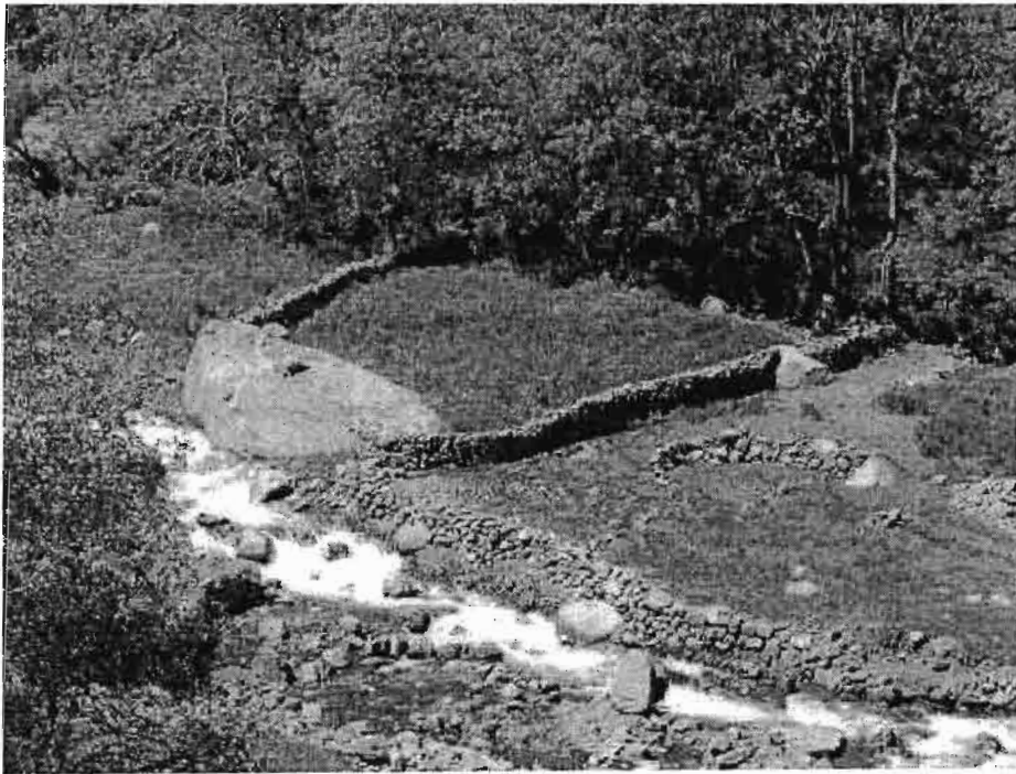
Photo 3. Murettes protégeant des parcelles au stade « graminées fourragères ». Noter la taille des blocs de pierre transportés lors des plus grosses crues.
