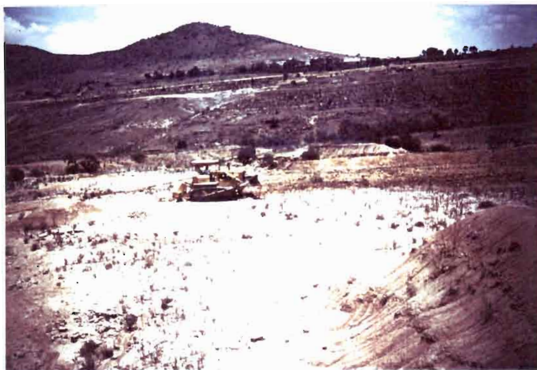
Photo n°5: Bulldozer procédant à un sous solage ou "roturation"
