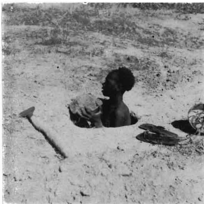
Fig. 4 — Bella IBAWAN creusant un puisard aux environs de Bankilaré.
