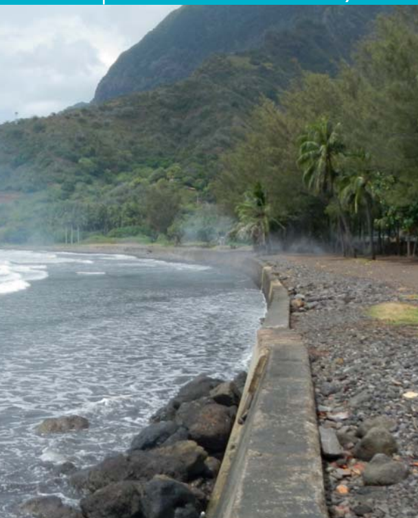
Muret construit aux Marquises pour la lutte contre les nonos des plages.
