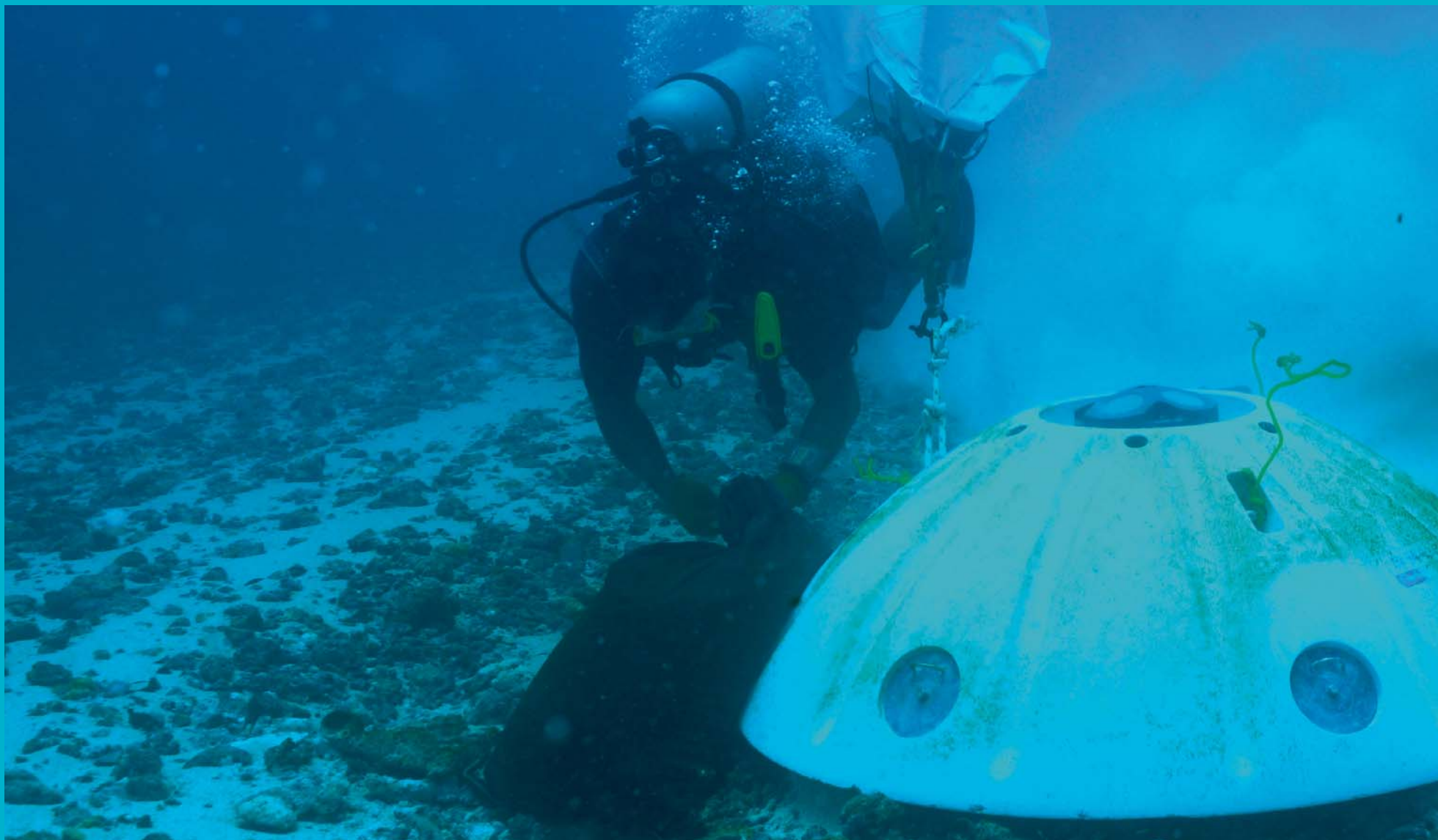
Installation d'un courantmètre dans la passe de Takaroa (atoll des Tuamotu). © J. Orepuller
