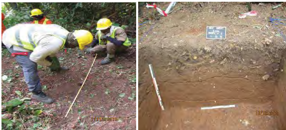
Photo 32 : Implantation et vue du Test Pit NAC/A/TP 004.
