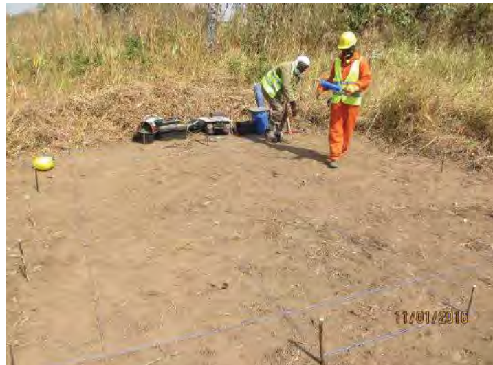
Photo 7 : Implantation du carroyage de NAC/B/012- secteur 2
