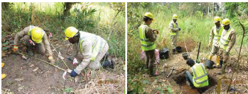
Photo 54 : Implantation et fouille du Test Pit NAC/C/007.
