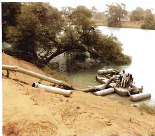
Station de pompage d'un périmètre irrigué villageois. Le groupe motopompe est installé sur un ponton flottant.
