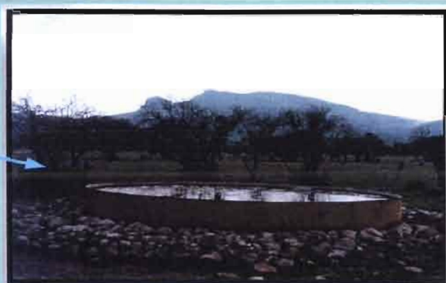
Abreuvoir en aval du réservoir
