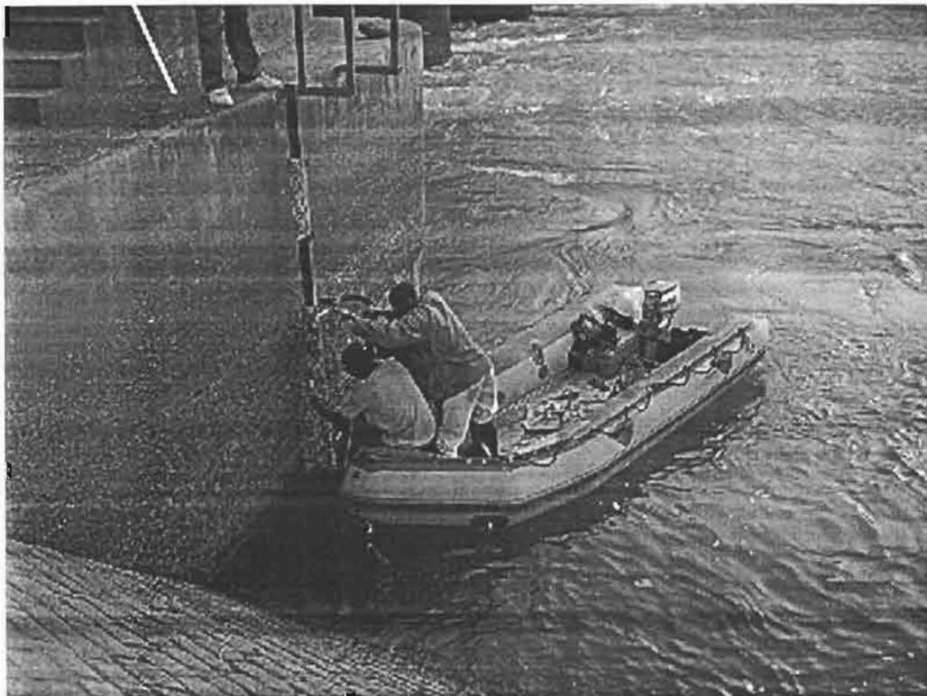
L'échelle en aval de l'ouvrage du Canal du Sahel est réhabilitée pour permettre la lecture de la cote aval.
