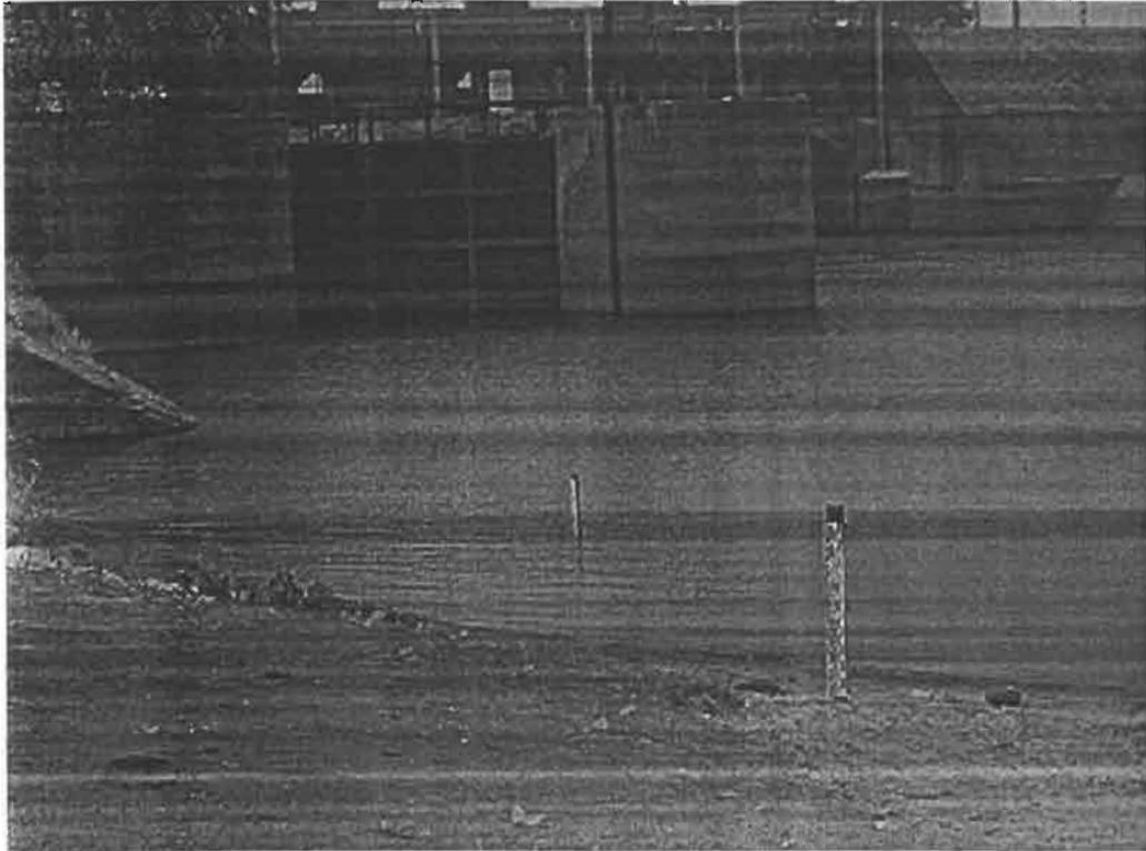
Deux nouveaux éléments d'échelle (8-9, 9-10) ont été installés en aval de l'ouvrage de régulation du Canal du Macina pour faciliter la lecture de la cote aval. L'ancienne échelle de fonte, dite de Markala, est difficile à lire et est soumise à d'importants remous.
