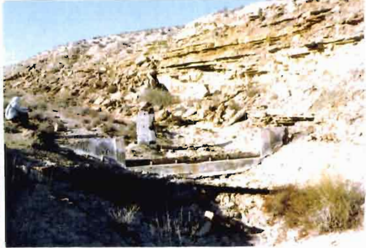
Les vestiges de la station du bassin de Zita V, on note encore la présence de la lame déversante et du puits du limnigraphe
