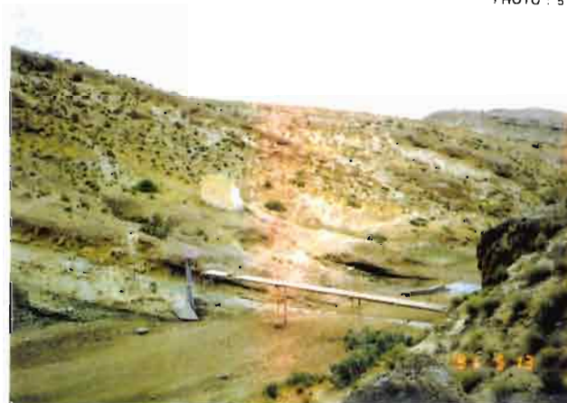
La station principale de L'oued Zita (Zita I) avec la passerelle de jaugeage et le puits du limnigraphe On note la section de mesures des débits de moyennes et basses eaux. Cette station fait partie du réseau D.R.E
