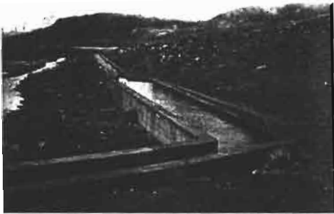
Figura 20: Tramo Milluni-Forebay del canal de Milluni. Enero 2009
