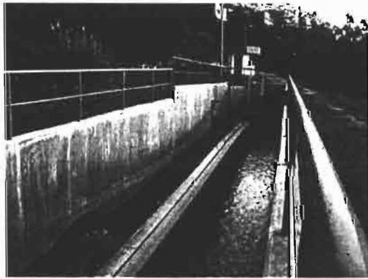
Figura 13: Llegada de las aguas de Milluni (a izquierda) y del Choqueyapu (a derecha) a la planta de potabilización Achachicala, 2009
