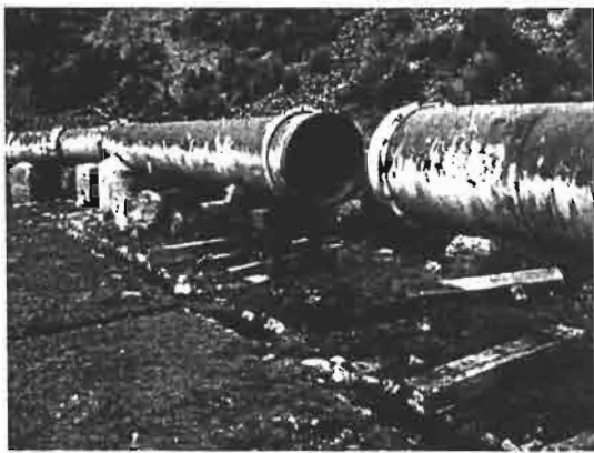
Figura 31: Antiguo canal de Milluni. Algunas partes no existen, por lo que el canal no es funcional. Marzo de 2009
