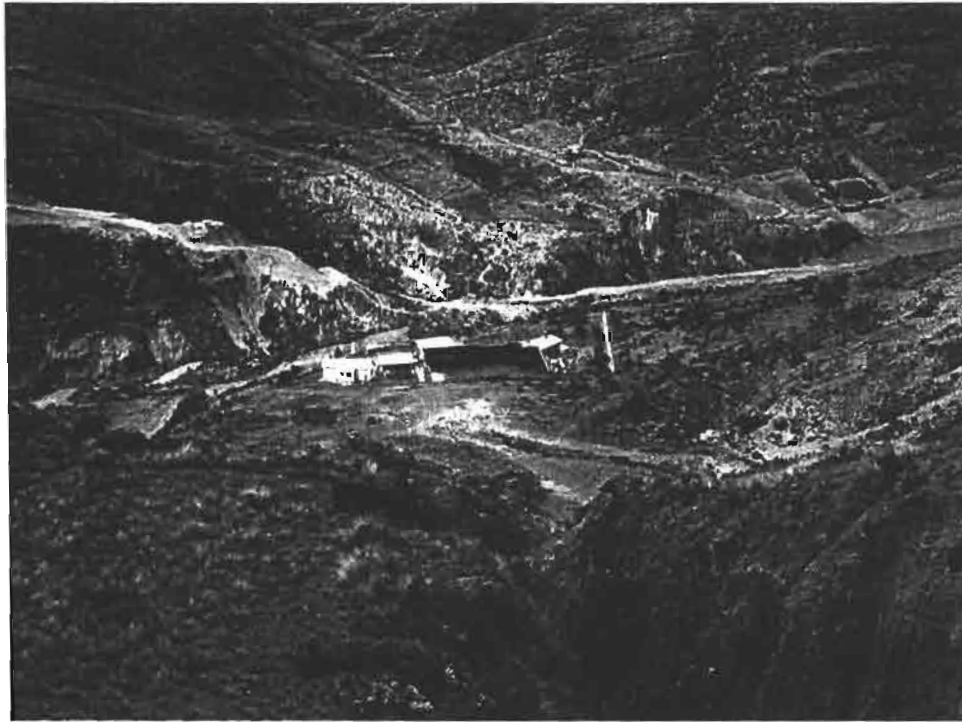
Figura 27: Estación rompecarga situada en una zona de deslizamiento de terreno. Marzo de 2009
