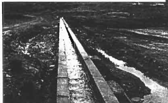
Figura 11 : Canal de Milluni, tramo Milluni-Forebay, 2009
