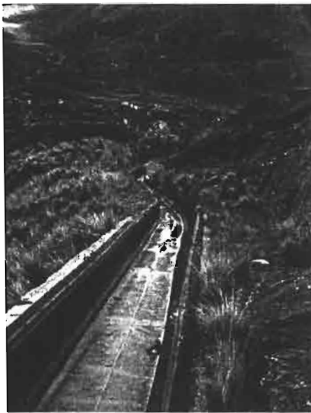
Figura 30: Aplicación de una cubierta de lona para impermeabilizar el fondo y las paredes del canal para reducir las fugas. Marzo de 2009
