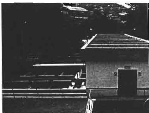
Figura 21: Los doce filtros de la planta tratamiento
