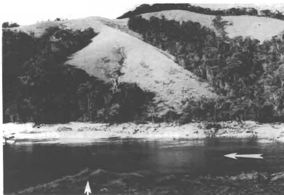
Photo 9 - Appui R. D. vu de la rive gauche
