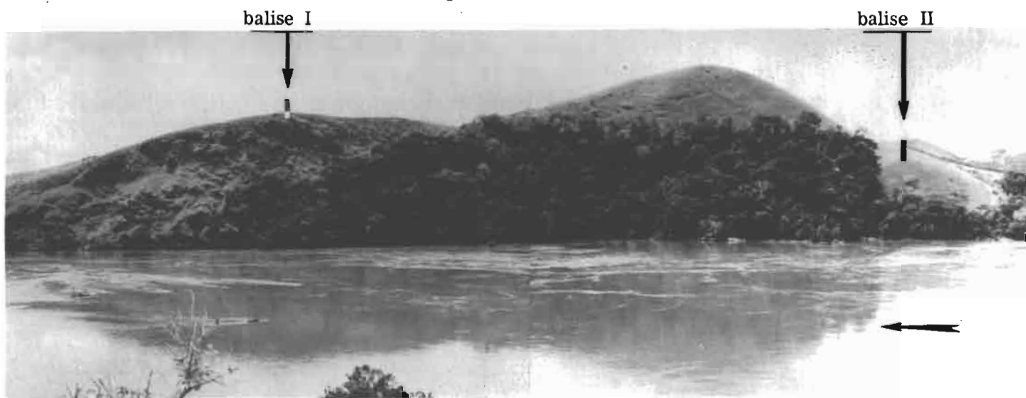
Photo 4 - APPUI RIVE DROITE et DETAIL de l'EPERON R. D. (vue prise de la rive gauche, au niveau de l'eau)
