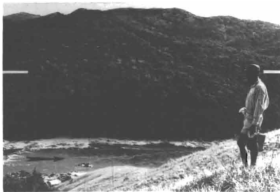
Photo 10 - Appui R. G. vu de l'appui R. D.
