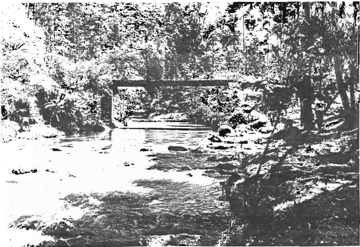
VISTA GENERAL DE LA ESTACION CON LA SECCION DE CONTROL
