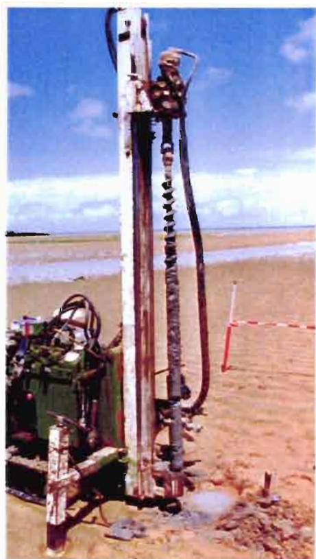
Photo 5 : Appareil de sondage à la tarière
