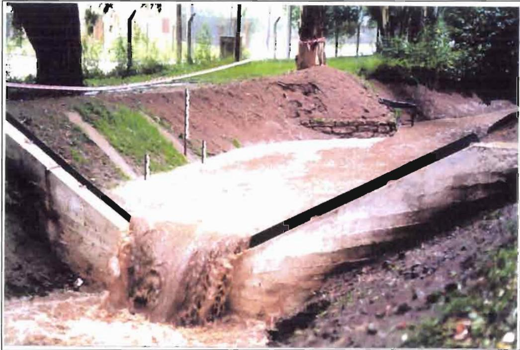
Figure V.19. Section hydrométrique de Villa Carlos Paz au cours d'une crue particulièrement chargée en sédiments.
