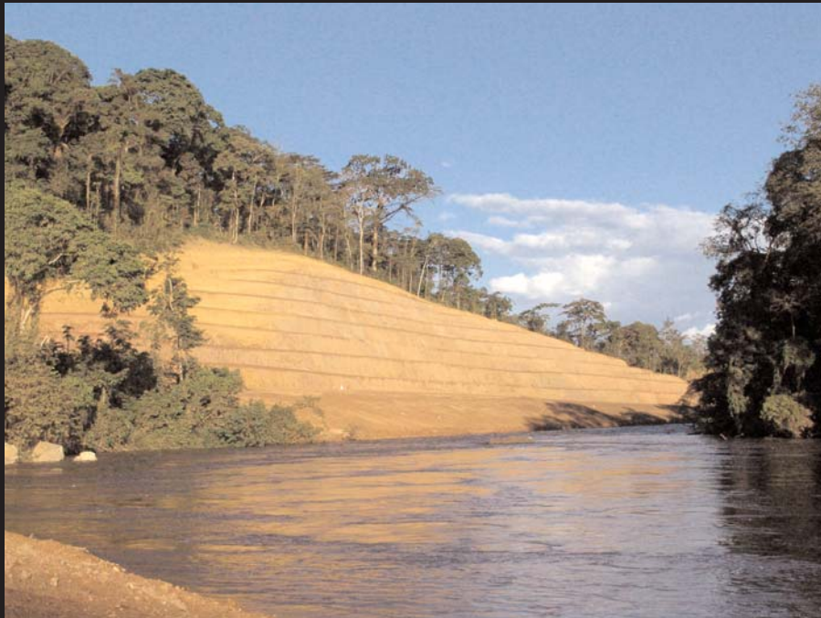
3. Grands travaux en risbermes (terrasses en escaliers) sur les flancs d'une colline qui domine l'Okano non loin de la petite localité de Benguié.
