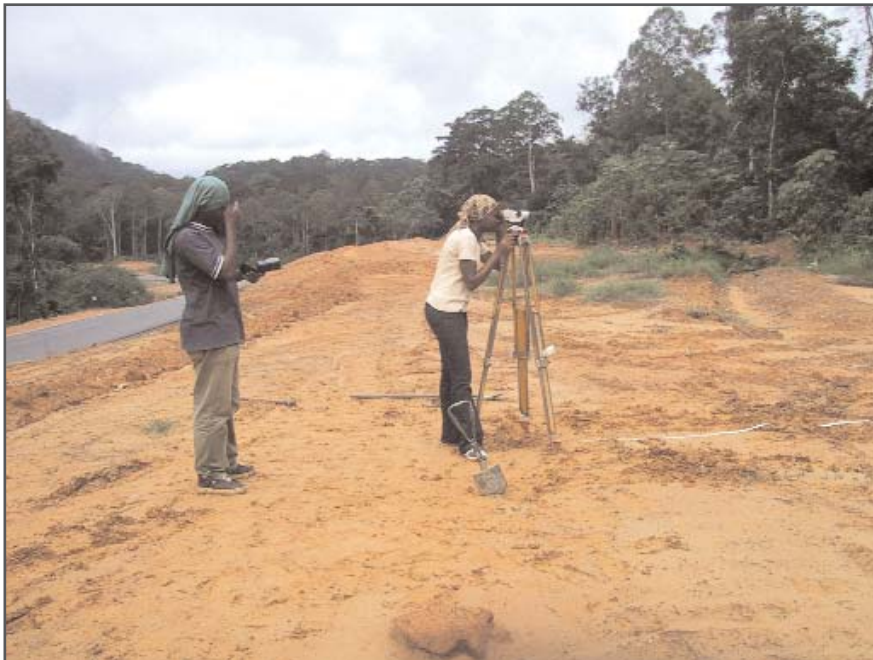
5. Formation des étudiants à la lecture du théodolite qui permet de positionner lors de relevés topographiques, les limites exactes d'un site.
