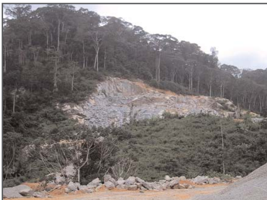
9. A la sortie de Viafé, un massif de diorite est exploité en carrière par la société de travaux publics Dragages Gabon.
