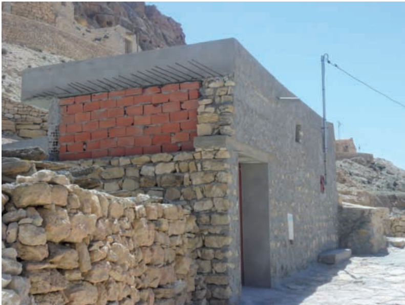
Figure 6. Photo d'une nouvelle maison construite (Nos photos, 2014)
