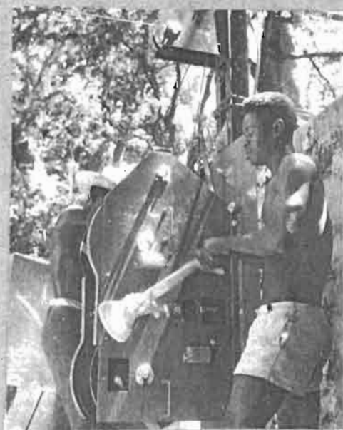
Manœuvre d'un treuil en cours de montage.
