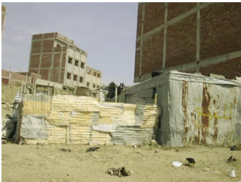
Quartier de recasement Kheir : constructions en cours et baraques «à vendre» Tanger (Maroc)
