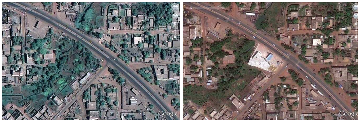
[Fig. 2a] Investissement en dur sur un « espace vert » en rive droite (Google Earth, février 2010 / avril 2011)
