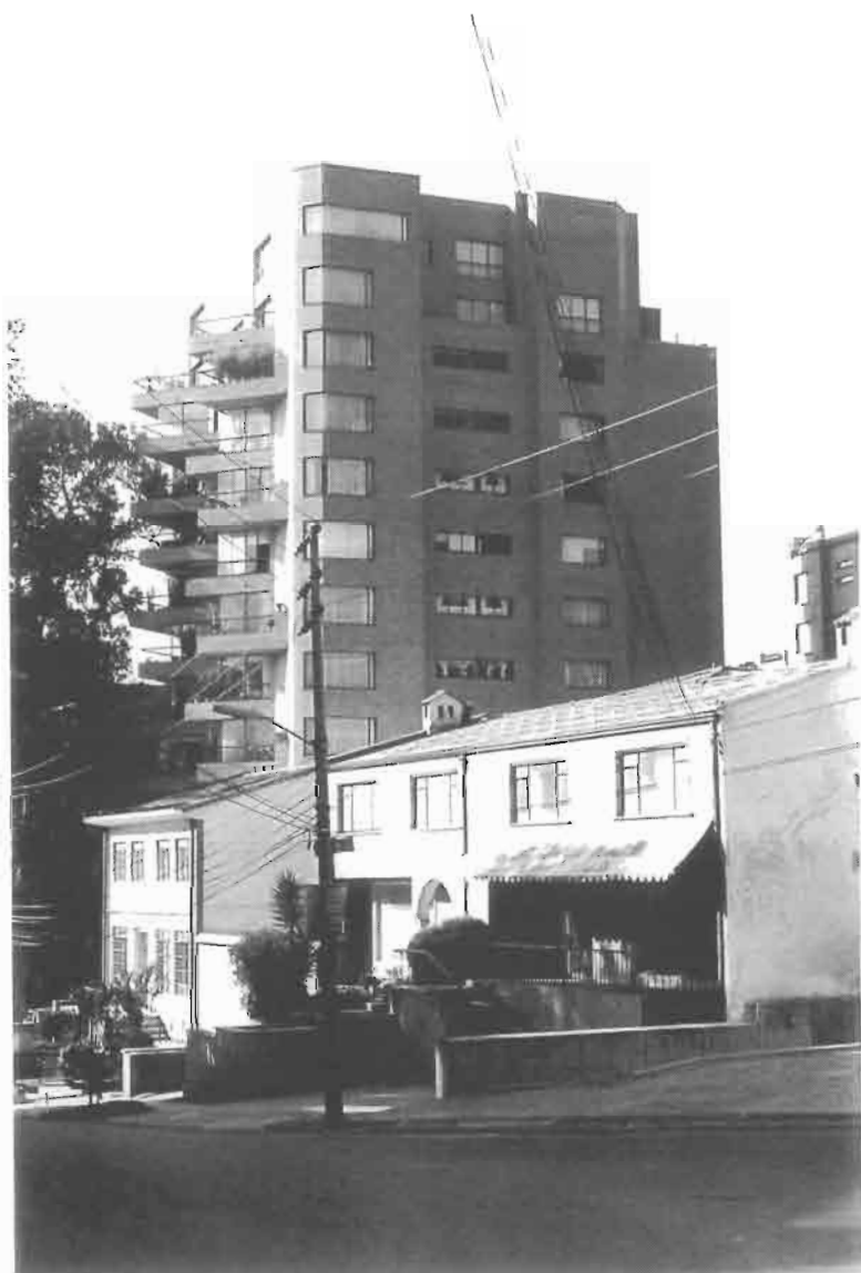
10. Quelques maisons, le plus souvent utilisées pour des commerces ou des bureaux, résistent à l'invasion des immeubles (Rosales, dans le péricentre nord de Bogota).
