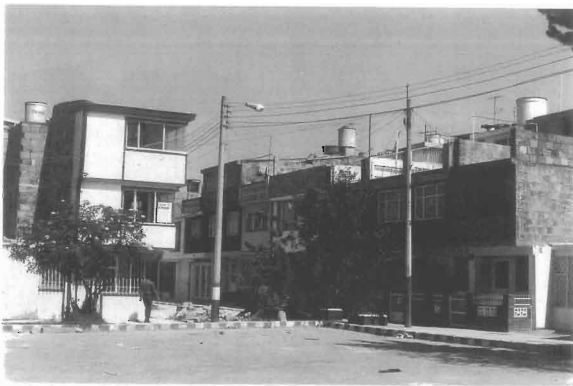
©Maria Cristina Hoyos 4. Après une dizaine d'années de consolidation de l'habitat et de pression sur les autorités pour la légalisation du quartier et le raccordement aux services publics, rien ne trahit l'origine illégale de ce lotissement clandestin de Bosa (sud-ouest de Bogota).
