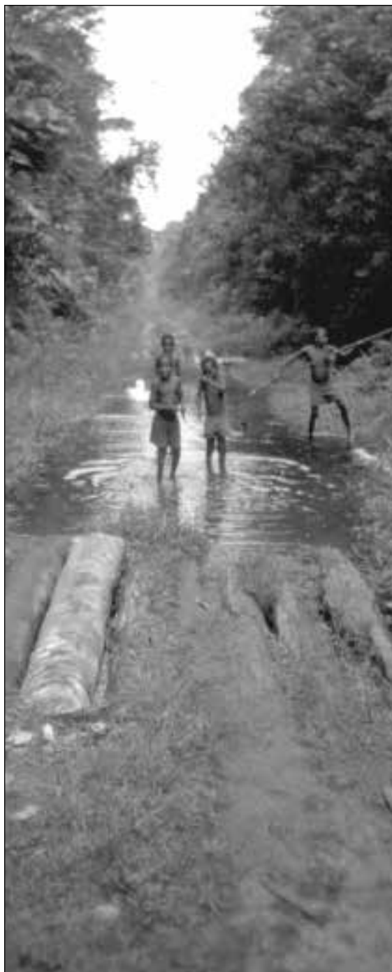
Le manque d'entretien des routes et leur utilisation à des fins d'exploitation forestière donne le résultat que nous constatons ici. La même route, à quelques mois d'intervalle. RDC. (cliché H.Pagézy)
