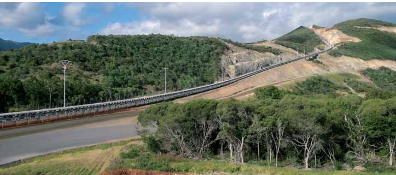
Le convoyeur de minerai de l'usine de Koniambo. Long de plus de 11 km, il peut transporter 700 tonnes par heure de minerai criblé et concassé de la mine à l'usine pyrométallurgique. © J.-C. Gay
