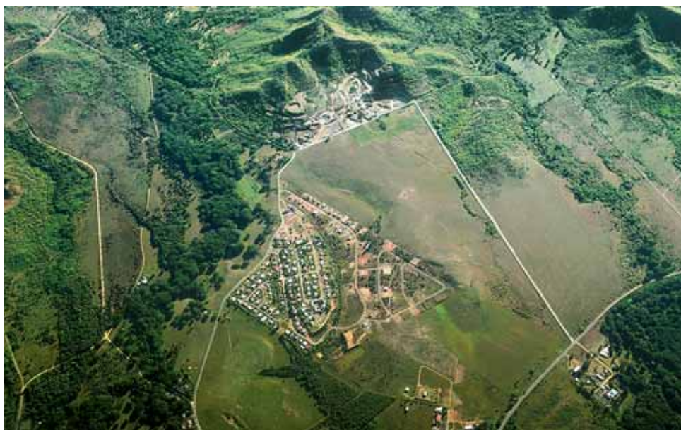
Lotissement en cours d'achèvement en 2010 à Koné.
