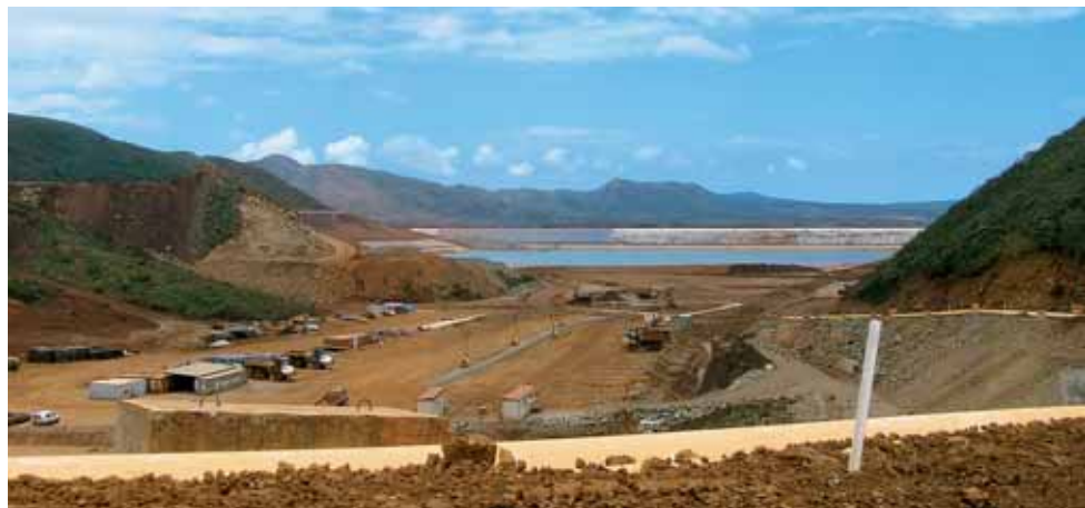
Cellule à résidus de l'usine du Sud (Yaté). D'une superficie de 130 ha, cette zone sert au stockage du « résidu minier épaissi », essentiellement du gypse et des oxydes de fer. © J.-C. Gay
