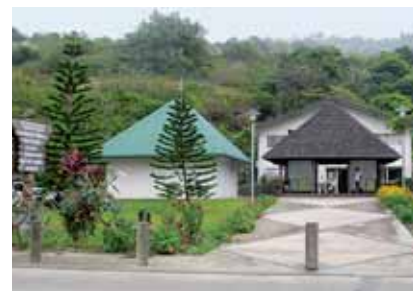
Bâtiments récents regroupant plusieurs services dans le chef-lieu de la commune de Hienghène.
