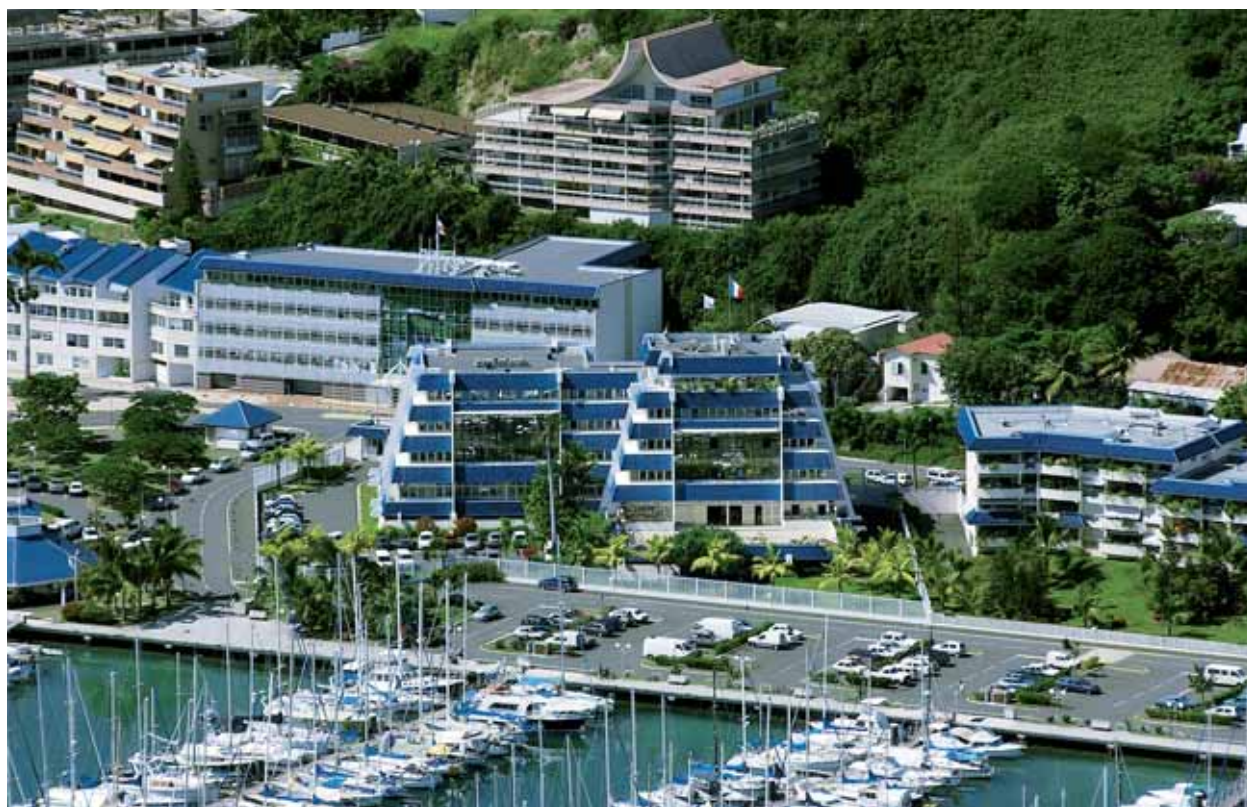
Bâtiments de la province Sud et du gouvernement en 2003. Ce dernier semble n'être qu'une annexe de l'hôtel de province, pyramidal et surnommé la « Maison bleue ».
