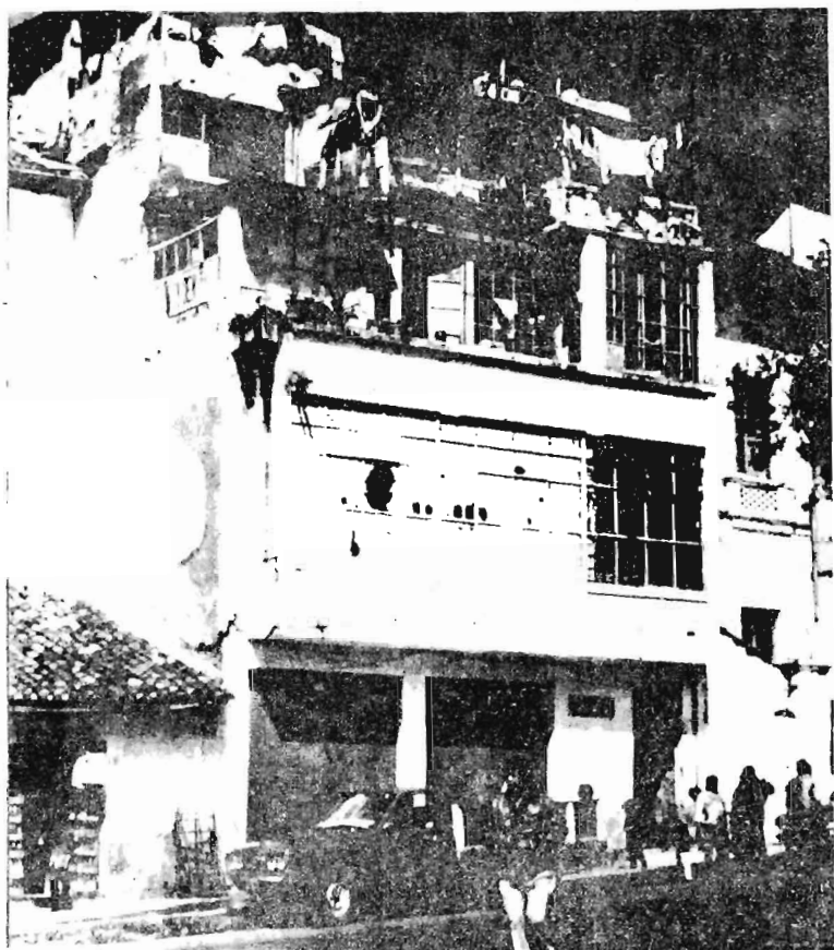
Foto 9 El centro de Quito: la tugurización vertical. Una construcción tradicional adosada a un edificio tugurizado en cuyo techo se construyeron cuartos (foto H. R. GODARD).
