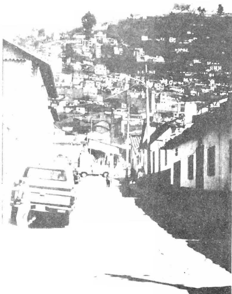
Foto 8 El centro de Quito. Las casas de un piso en adobe con cubierta de tejas (Foto H. R. GODARD).
