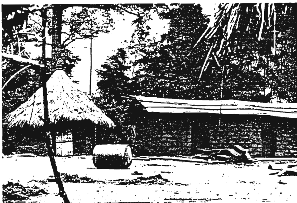
Construction d'une case en brique de terre Paysage de la plantation continue
