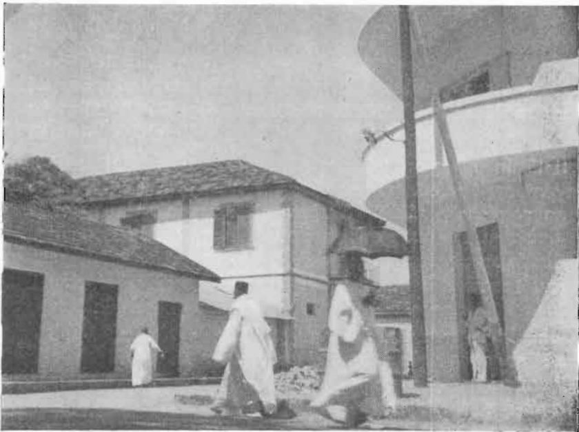
Contraste : à gauche, vieille factorerie n'ayant subi aucune modification à droite, ancienne maison de commerce modernisée.
