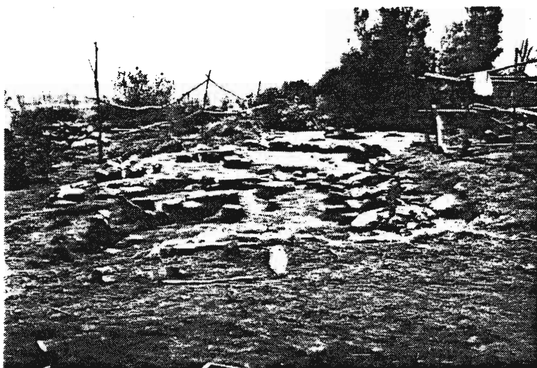
Vue du sud (habitations 1, 2, 3 et 4)
