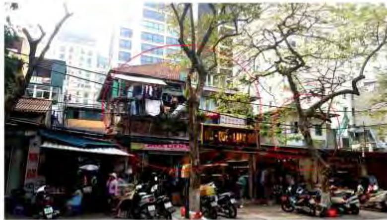
Villa in Quan Su street
