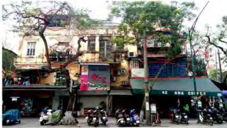
Villa in Quan Su street
