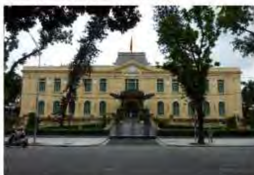
Government guesthouse (Hôtel de la Résidence Supérieure. Arch.A. Bussy)
