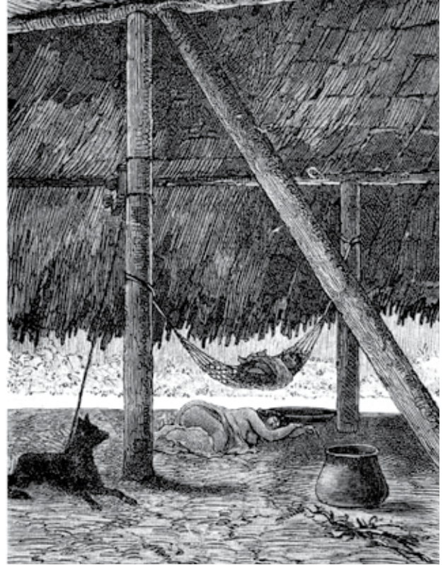
Poste inclinado en una choza indígena a orillas de Samiria Grabado de P. Vignal, en Charles Wiener, 1882
