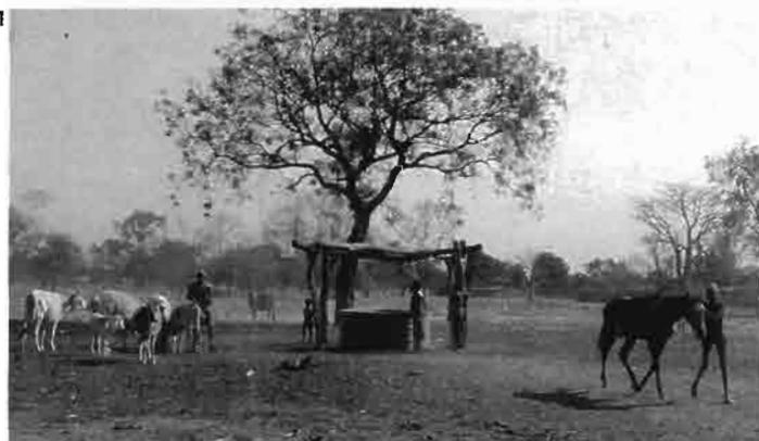
**Photo 2**, exhaure de l'eau d'un puits par traction d'un **dromadaire** au Niger. Système d'irrigation appelé **délou**.
