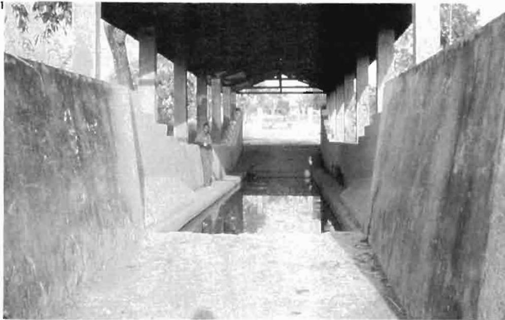
Photos 1 à 4, bains détiqueurs à Wakwa, Cameroun. **Photo 1, vue générale** d'un bain construit surtout en béton, avec toiture pour éviter la dilution du produit de traitement par les pluies.
