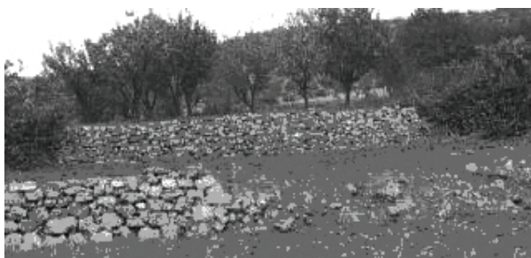
Photo 3. Juxtaposition de l'entretien et l'abandon des ouvrages de GCES
