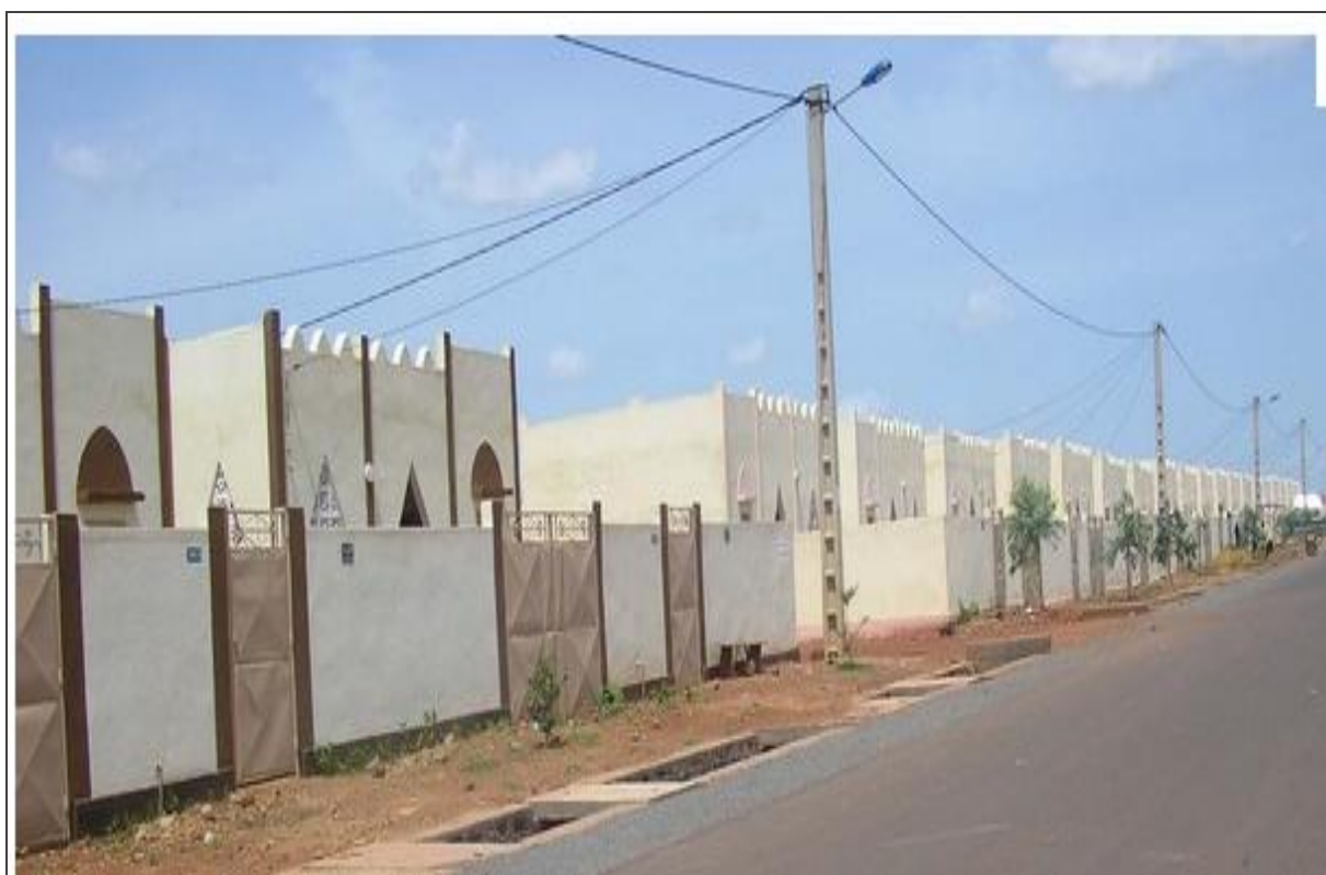
Figure 164: Aperçu des logements sociaux de N' Tabacoro dans la périphérie du District de Bamako (Maliweb, 2015)
