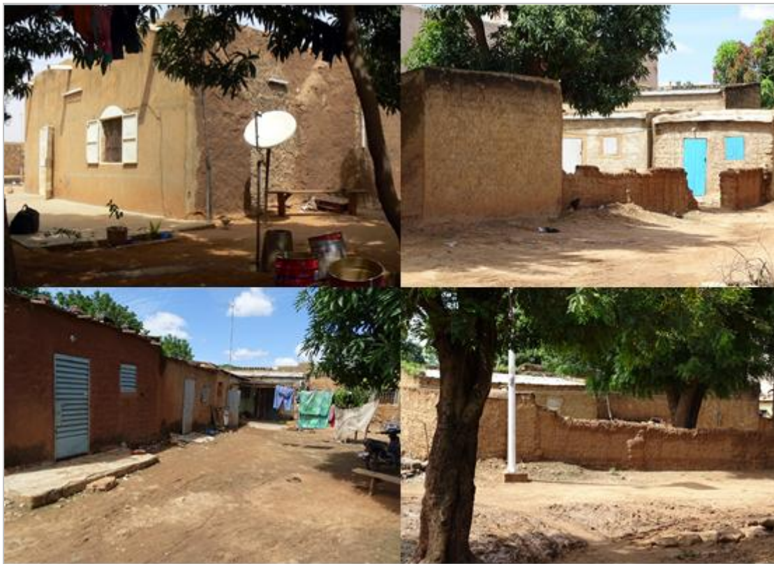
Figure 102: Image des logements à bas standing
