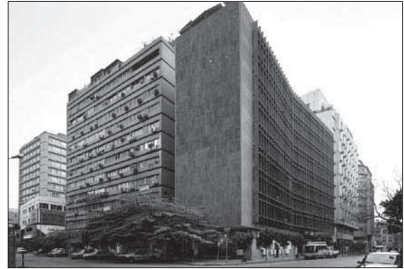
Fig. 2.24 Bâtiments du ministère de la santé, construits sur le site de Shephard. © A.Bonnamy
