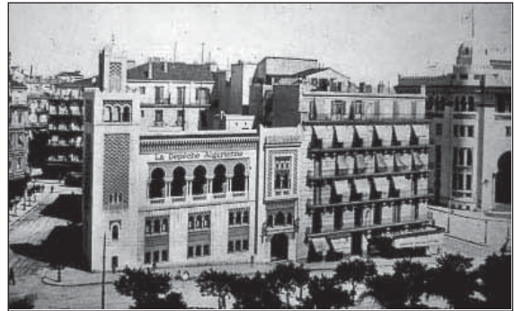
Fig. 1.25 Immeuble de la Dépêche Algérienne, Henri Petit, architecte, 1905, carte postale 1910. Carte postale, fond des auteurs.
