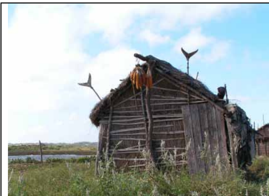
Photo 16 : Queues de gros poissons sur le toit d'une maison
