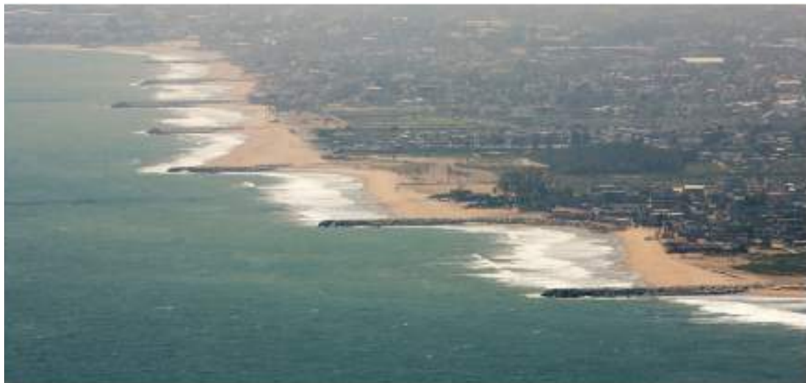
Figure 13 : Batterie d'épis de protection, installés à l'Est de Cotonou,
