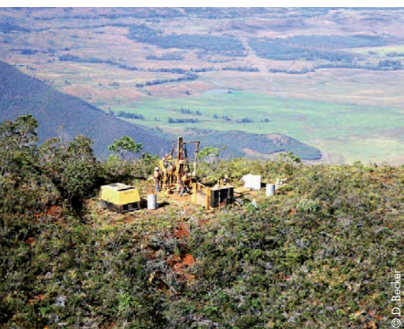
Un sondage au sol
