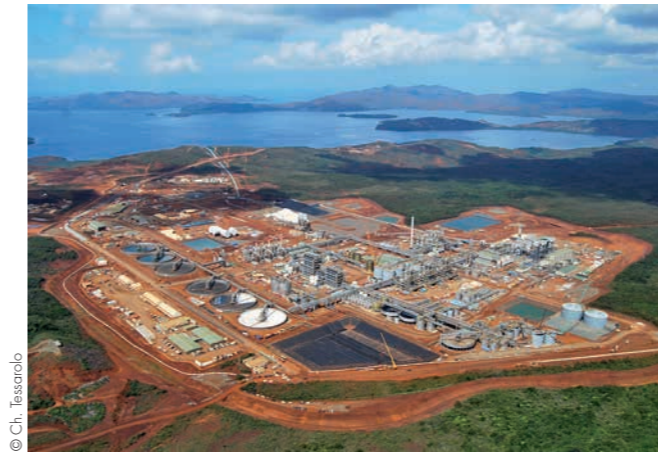
Le site industriel
