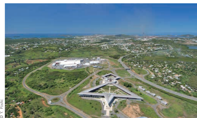
Le lycée du Grand Nouméa et le centre commercial Kenu-In
