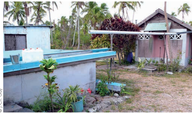
Dispositif de récupération de l'eau de pluie à Tiga
