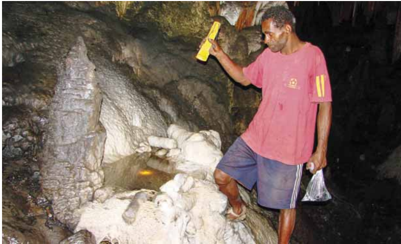
Vasque artificielle constituée de blocs de stalactites brisés, construite dans une grotte de l'île de Tiga pour récolter l'eau d'infiltration. © C. Sand
