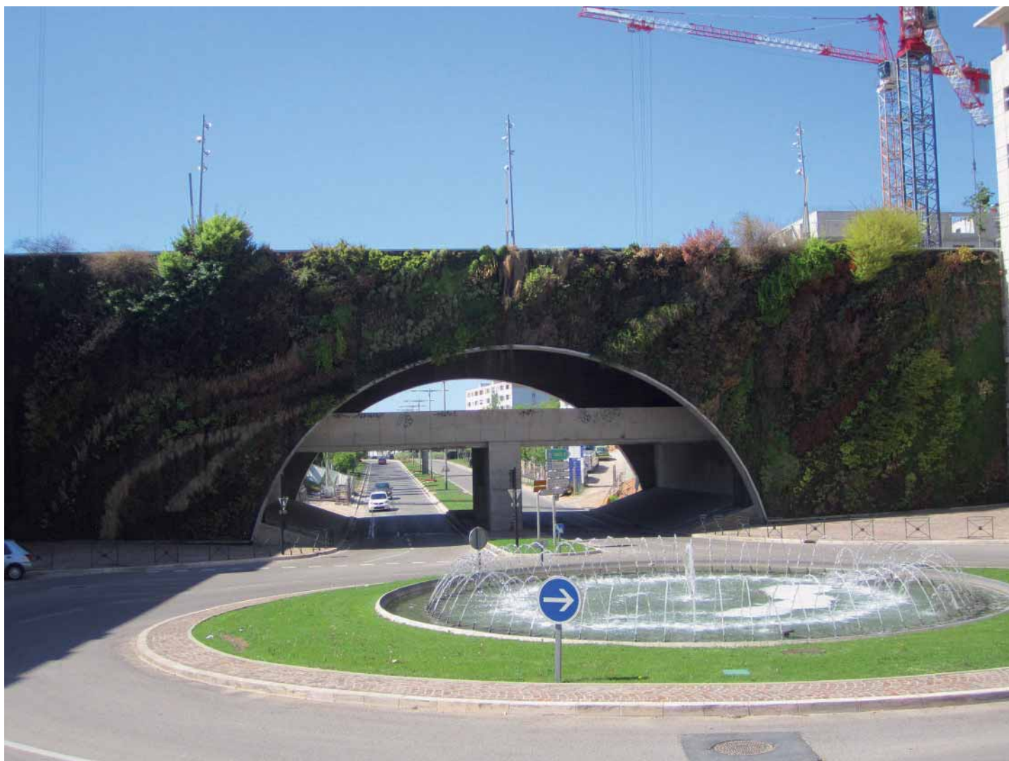
Photo 14. Mur végétalisé, Aix-en-Provence
