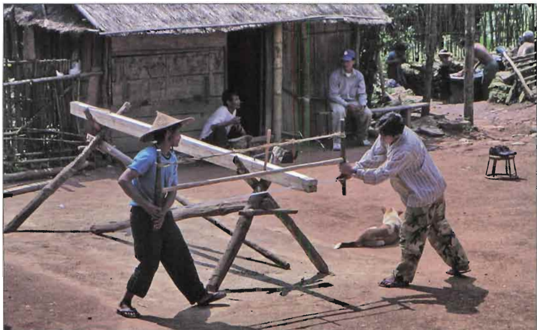
Sciage à plat de planches pour la construction d'une maison (Kômèn, 7/2006).
