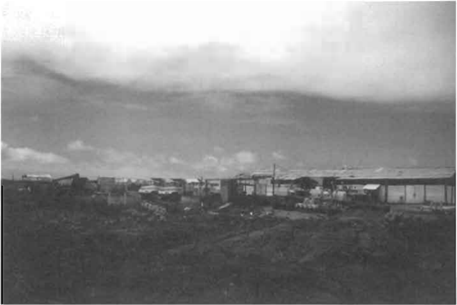
Campamento del INGALA en Puerto Villamil. La maquinaria nueva ha sido traída para terminar la construcción del aeropuerto de Isabela. Estos campamentos establecidos en las zonas de uso especial del PNG ilustran la prioridad del Estado en las Galápagos: incorporarlas al territorio nacional y al mercado turístico mundial mediante la construcción de infraestructuras de transporte.
