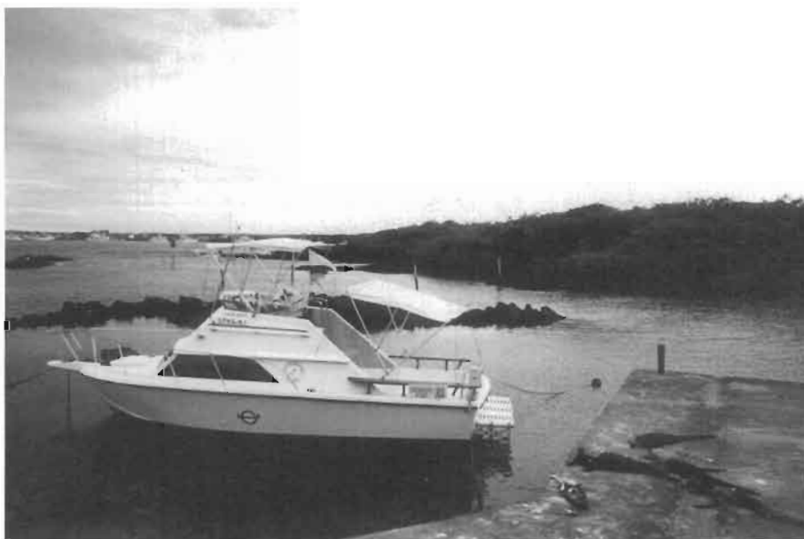
El muelle del SPNG sirve de solarío a las iguanas marinas: instalado en una caleta de Academy Bay bordeada de manglares y arrecifes, concuerda con la modestia de las embarcaciones encargadas de la vigilancia del PNG (este esquife es una donación de la UNESCO).
