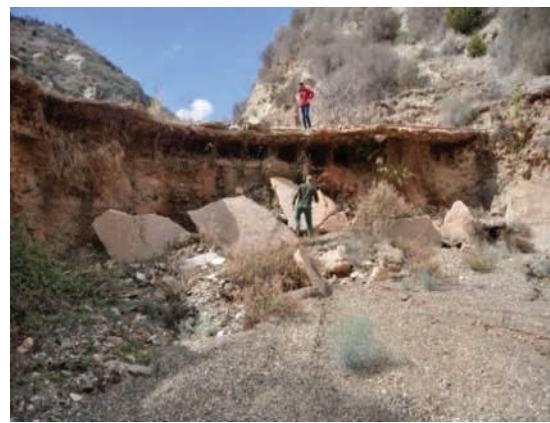
Figure 9 : (a) État initial du seuil n°18 du sous bassin Seftoula ; (b) Son état actuel d'endommagement
